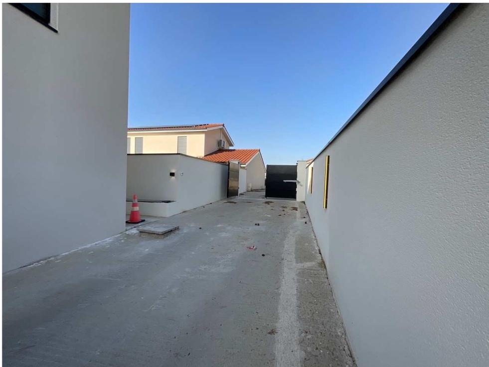
Une allée, constituée d'une dalle en béton, délimitée par la façade de la maison et le mur de clôture, revêtu d'un enduit à l'état neuf, surmonté d'une couvertine plate donne accès à l'arrière du terrain. Une jardinière est aménagée le long de cette allée.
